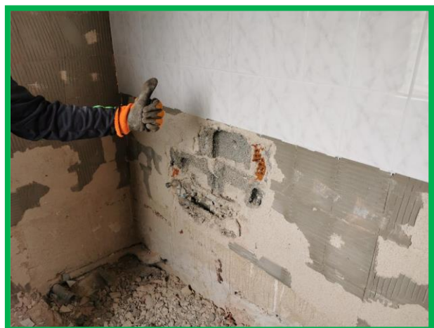
Erste Arbeiten im Vereinsheim
